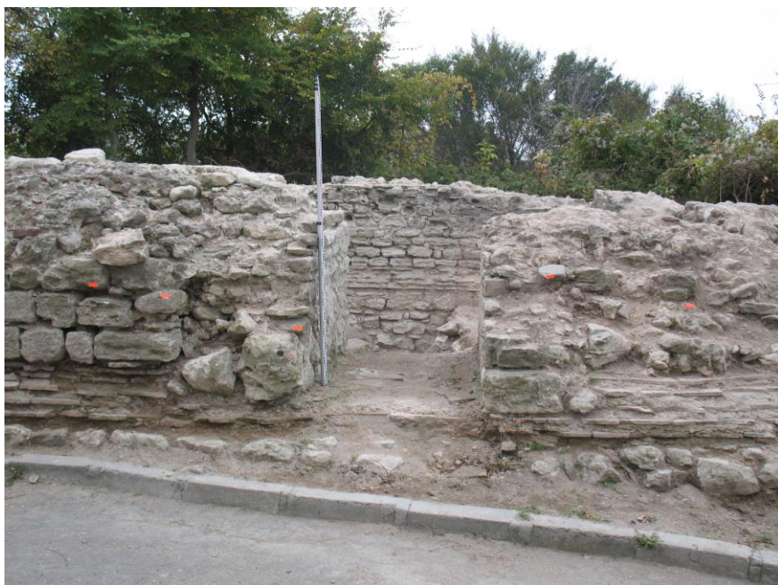
Крепостната стена откъм полуострова и вход в кулата
